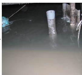
洗浄作業終了
