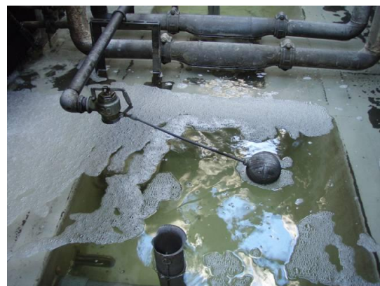
水管洗浄中の状況
