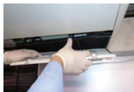
吸込みグリルとフィルターの間に挟み込む
