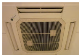
設置完了 2枚/台
